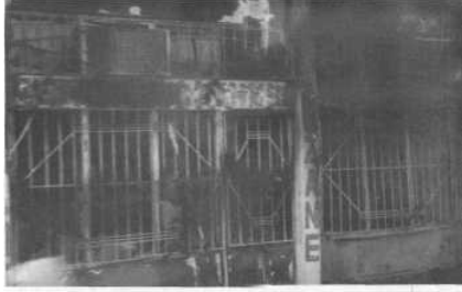
Kulp'ta birçok işyeri ve ev tahrip edildi, binlerce kişi göç ettirildi... Olğarşı- lıştığı belirtiliyor. İlçede bulunan 600-700 kişinin çoğunu da Kulp'ta akrabası, yakını bulunan, Diyarbakır ve çevre ilçe ve köylerden gelen insanlar oluşturuyor. İlçede birçok işyeri tahrip edildiği ve yüzlerce insan da göç ettiği için, kalan insanların acil (gıda vb.) ihtiyaçları, gelen yardımlarla karşılanıyor.
